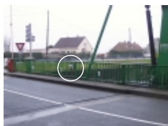
Surveillance de pont levant
