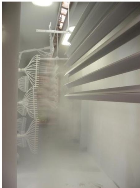
Figura 1 - Cabine de pintura por electrodeposição
